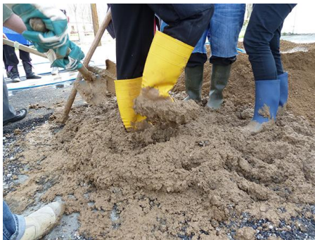
Στιγμιότυπο από το φύση/όρια/υλικά του 2011. Η κατασκευή των πλιθίων
