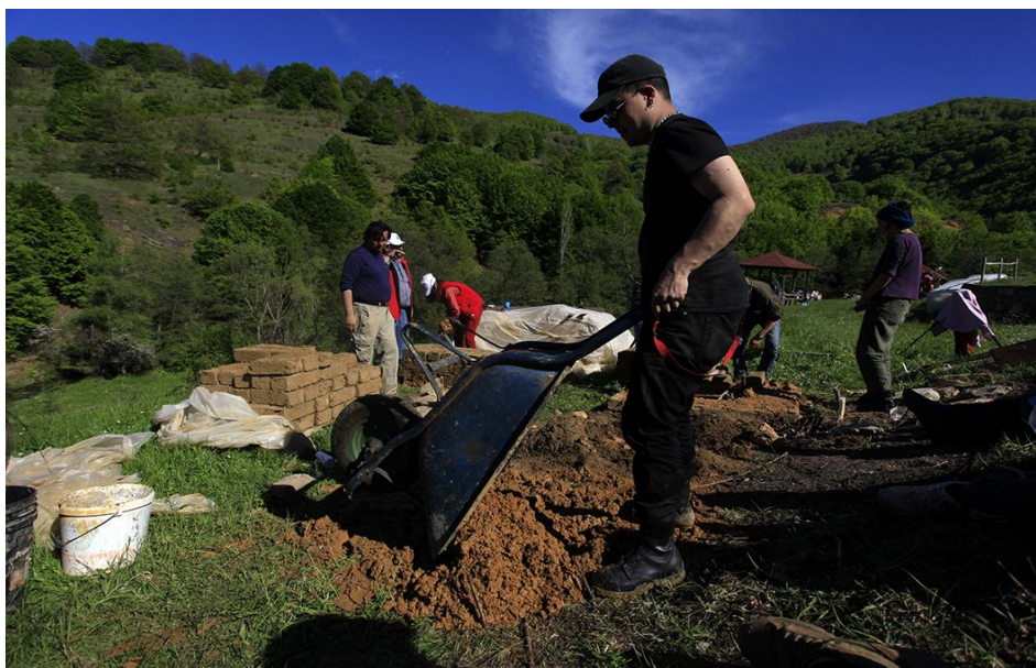
Στιγμιότυπο από το φύση/όρια/υλικά του 2011. Η κατασκευή του πορτονιού
